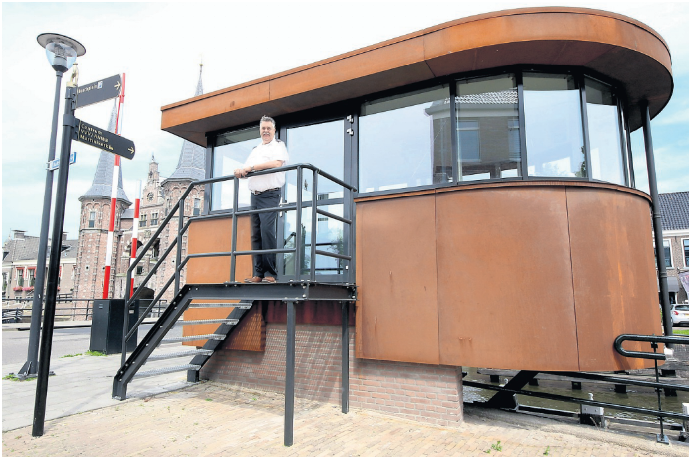
Het nieuwe brugwachtershuis is de werkplek van onder meer Peter Scholte. Foto: Simon Bleeker
