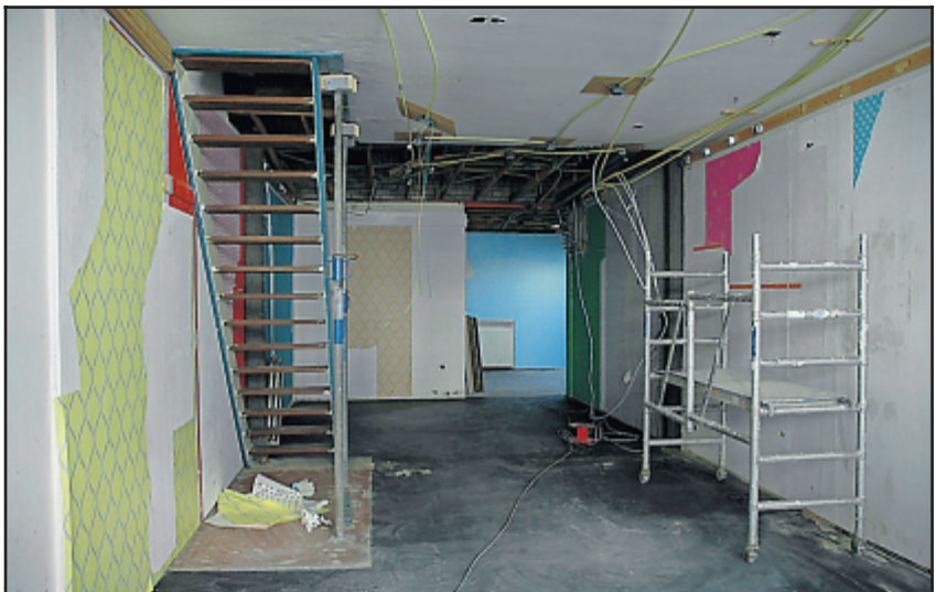
De benedenverdieping nog met trap die wordt verplaatst
