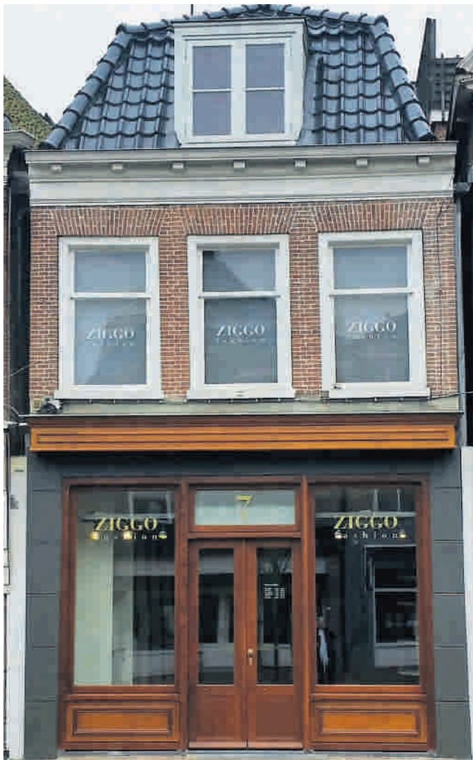
De nieuwe gevel van Ziggo Fashion aan het Grootzand 7 in Sneek.
